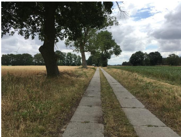
Abb. 14: Der die Ortschaften Kantow und Blankenberg verbindende Betonplattenweg ist für die Anlage der Zuwegung für den Schwerlastverkehr auszubauen (Blickrichtung Süd)
