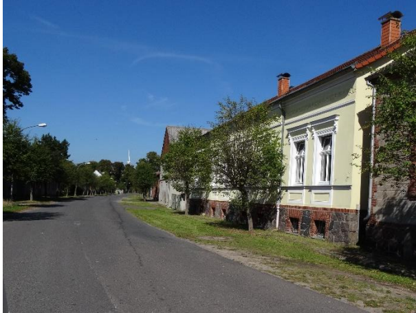
Abb. 10: Dorfstraße in der Ortschaft Kantow
