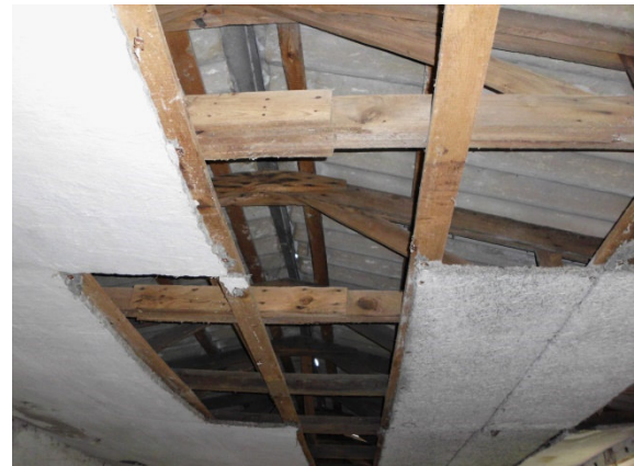
Abbildung 8: Dachfläche in den Ställen, zugänglich, G4
