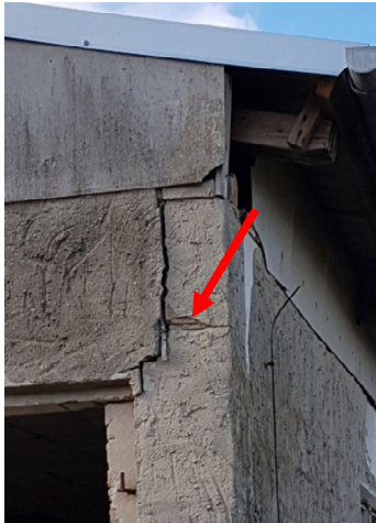
Abbildung 18: Gebäude G3 mit Brutplatz des Gartenbaumläufers
