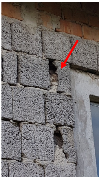
Abbildung 16: Gebäude G4 mit Brutplatz des Grauschnäppers
