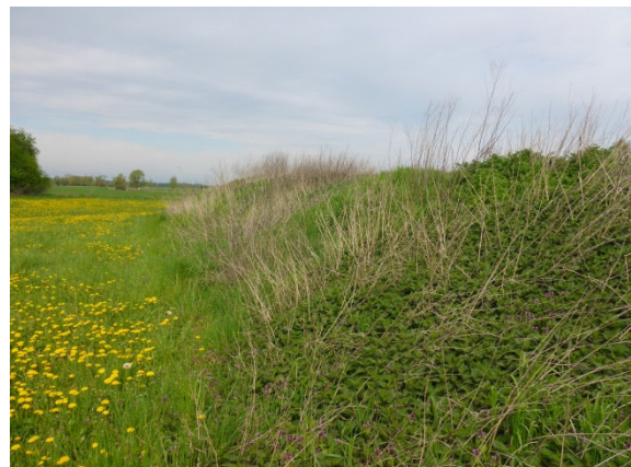
Abbildung 13: Anschüttung an das Silo B4, Brennesseln
