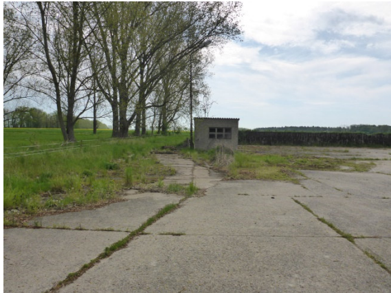
Abbildung 3: Zufahrt betonierte, Wiegehaus G5, Betonfläche B3
