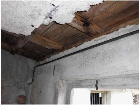
Abbildung 32: Nischen unter Dachverschalungen
