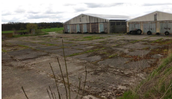
Abbildung 17: Ansicht vom Silo in Richtung Ställe (hier PV auf dem Dach)
