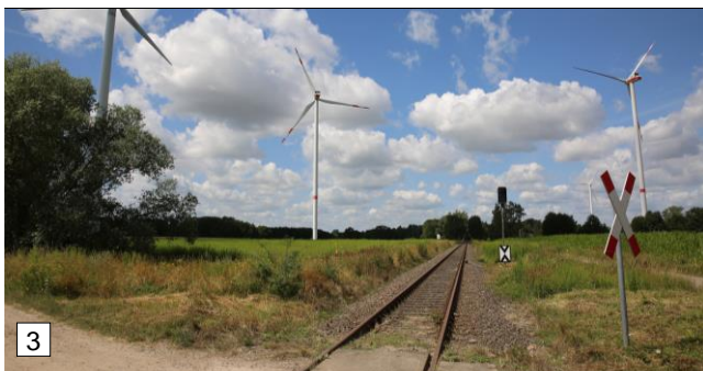
Bild 3: Eine Bahntrasse durchquert das Plangebiet im südlichen Bereich. Ein Eingriff in diese Bereiche wird nicht vorbereitet. Die Gleisanlagen bleiben unverändert.
