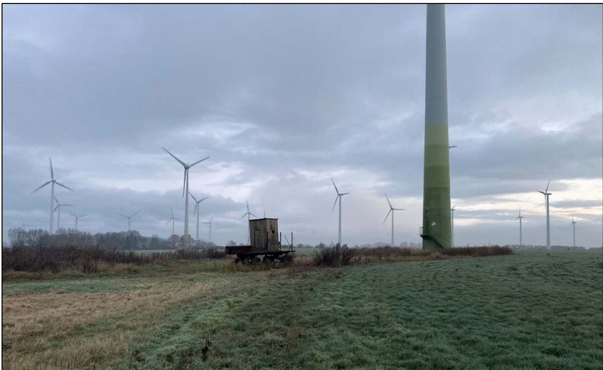
Abb. 9 Blick in den Bestandwindpark
