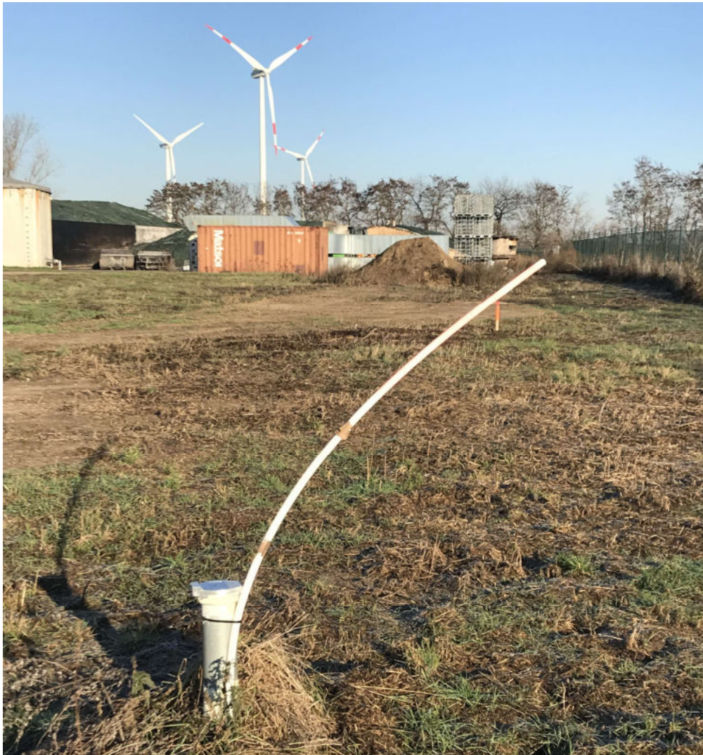
Gewerbebrache (2018) wird überbaut, Grundwassermesspegel wird versetzt.
