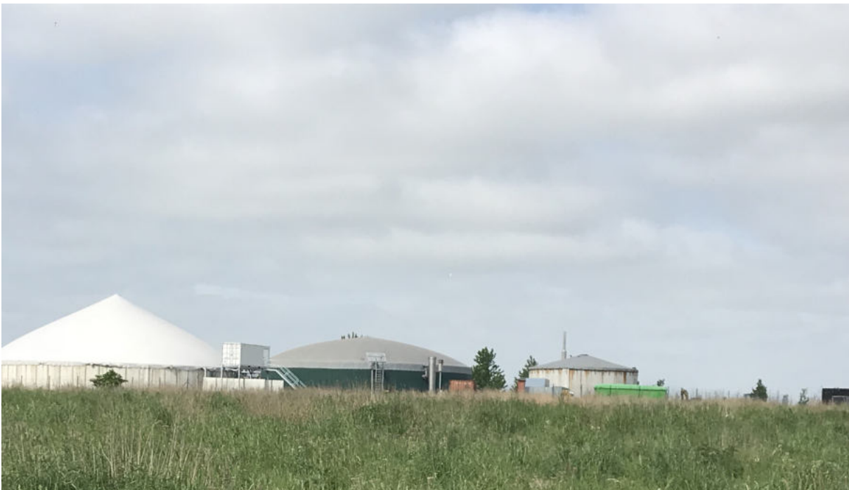
Begehung Mai 2018 (Blick von Osten auf die Biogasanlage)
