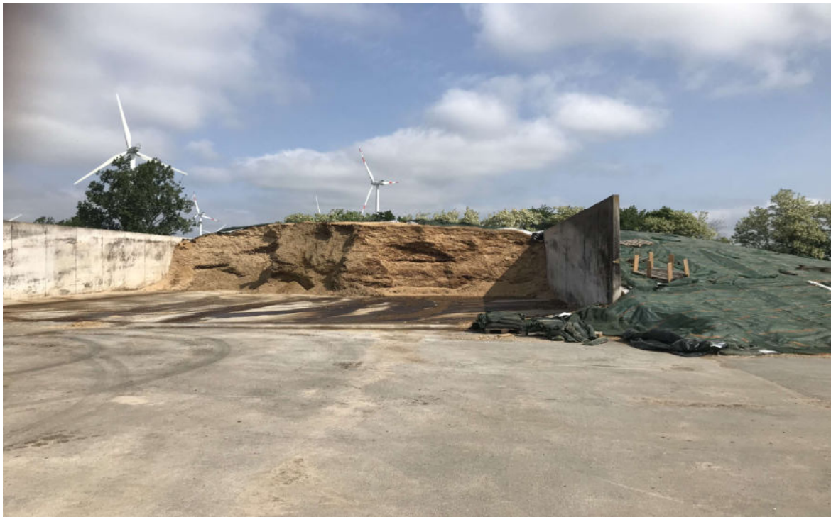
Biogasanlage befestigte Bewegungsfläche und Silo
