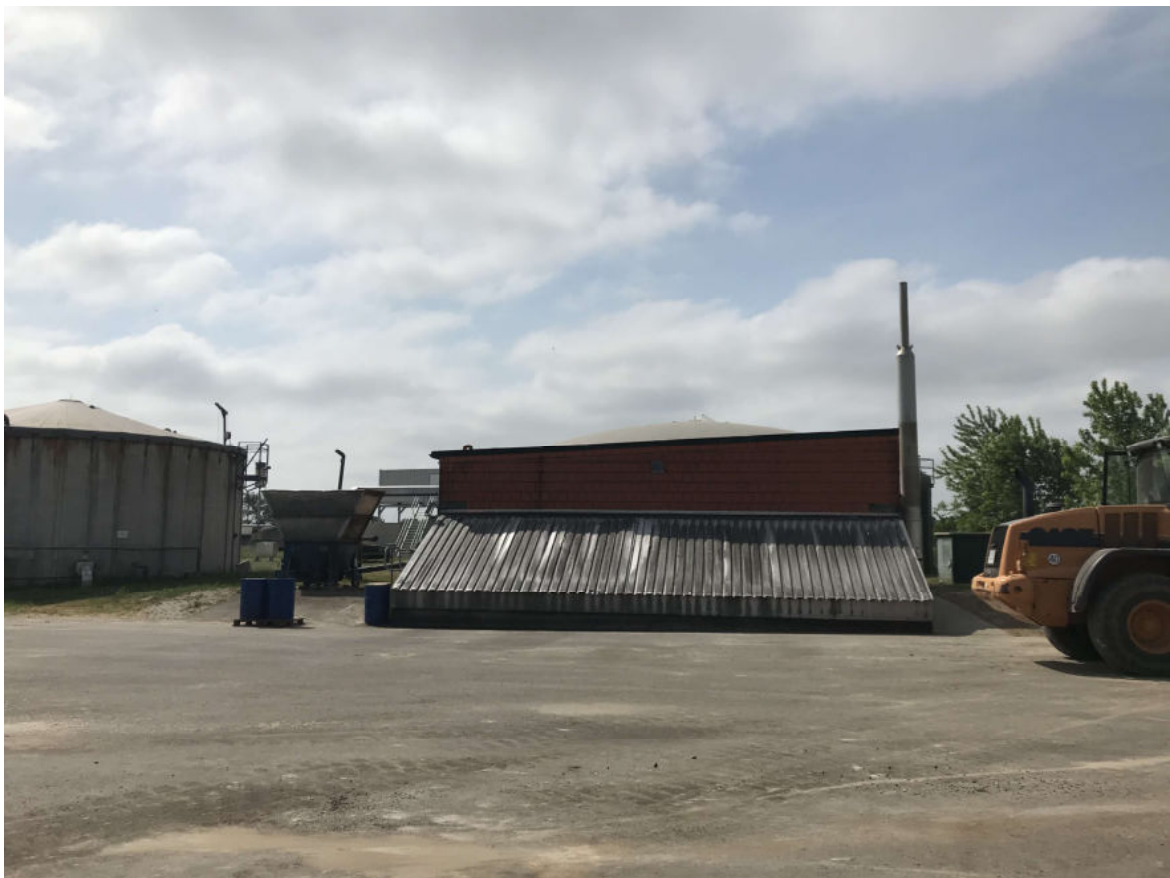
Biogasanlage befestigte Bewegungsfläche und Technikgebäude mit Annahmehunker (2018)
