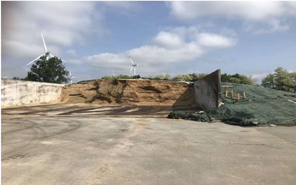
Biogasanlage befestigte Bewegungsfläche und Silo
