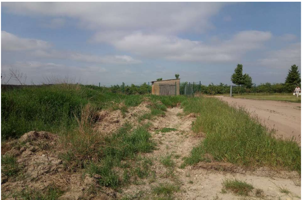
Teil-Bereich BGA Südgrenze (Kadaverhaus im Hintergrund- neue Zufahrt wird neu versiegelt) (2018)
