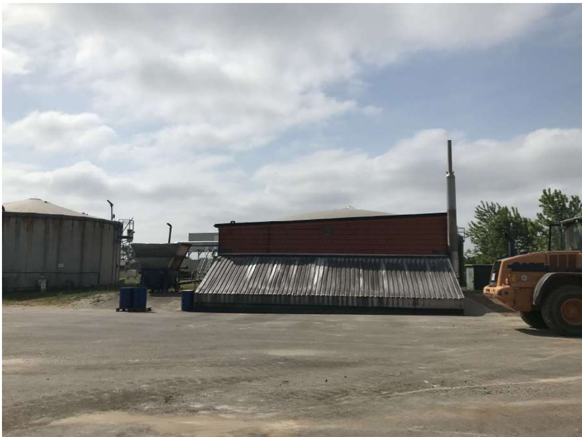
Biogasanlage befestigte Bewegungsfläche und Technikgebäude mit Annahmehöcker (2018)
