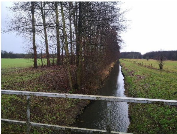
Abbildung 9: Siepgraben, Foto am 18.02.2023
