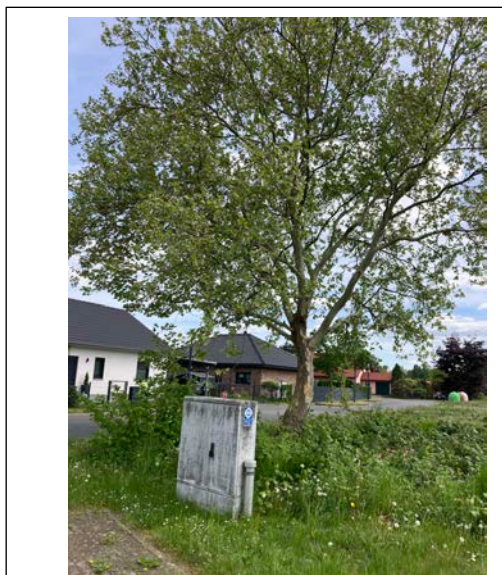
Abb. 11: Bestandsbaum Platane (Erhalt), Ver- und Entsorgungsanlagen (Abwasserpumpwerk und Schaltkasten)
