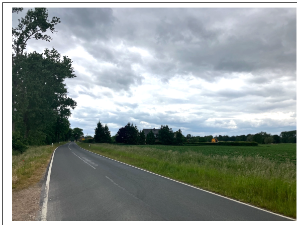
Abb. 1: Brunner Straße, Blick Richtung Südwesten
