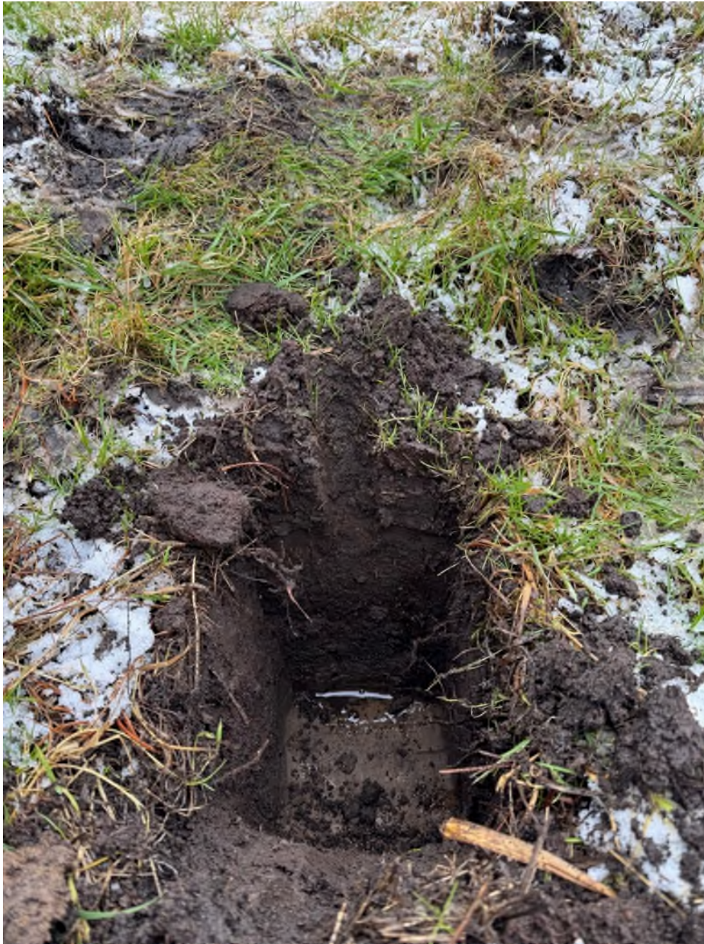
Abbildung 11: Schurf Nr. 4, stark vererdeter Torf bis 35 cm Tiefe, in der Lochsohle sieht man den lehmigen Untergrund und sammelt sich schon das Wasser
