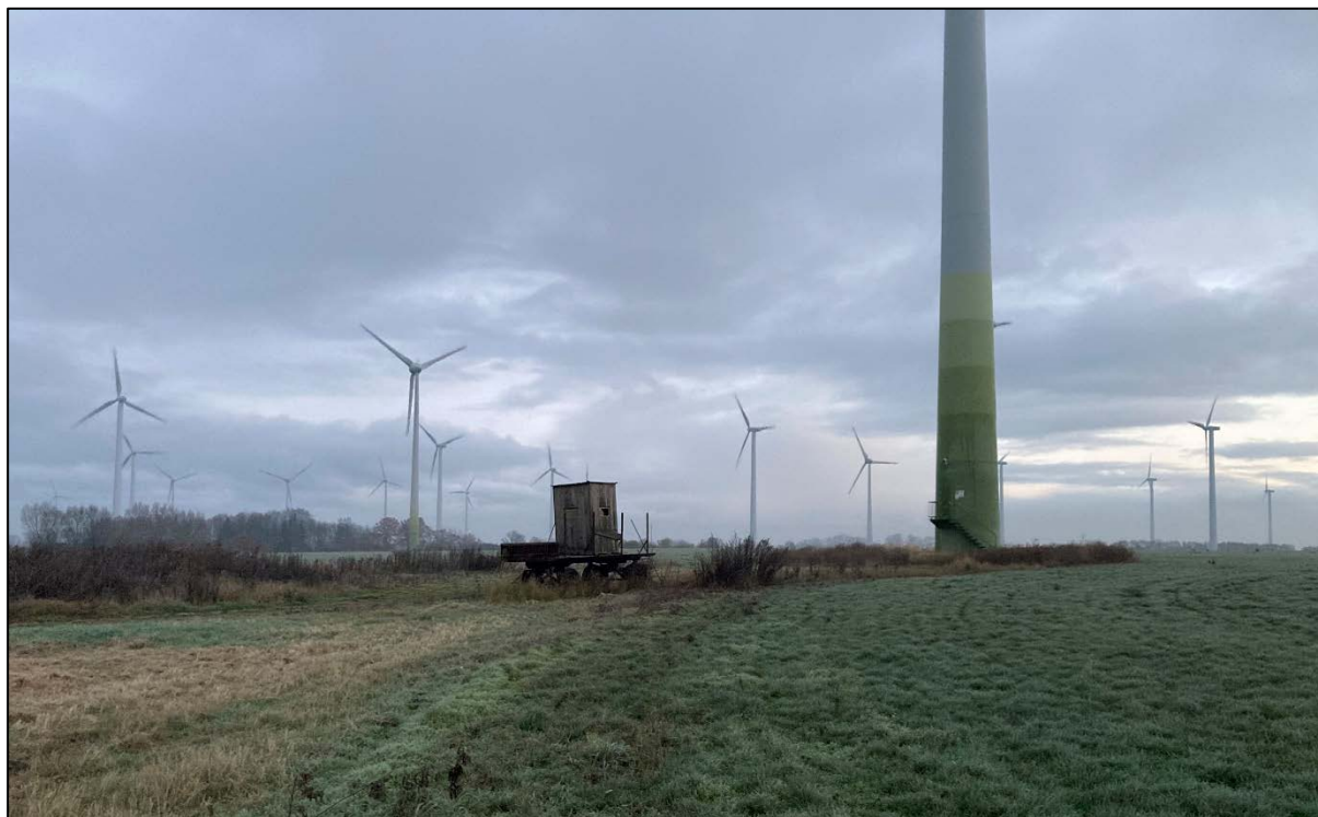
Abb. 6 Blick in den Bestandwindpark (Foto: P. Franke)
