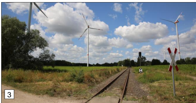
Bild 3: Gleisanlagen durchqueren das Plangebiet im südlichen Bereich. Ein Eingriff in diese Bereiche wird nicht vorbereitet. Die Gleisanlagen bleiben unverändert.
