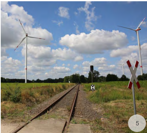
Abb 5: Bahntrasse am südlichen Rand des Plangebietes.
