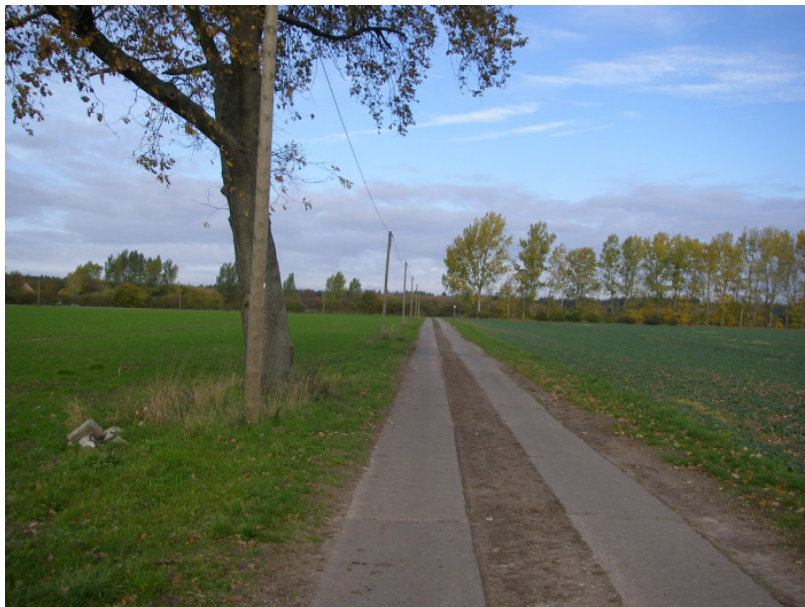
Abb. 27: Blick auf den mit Spurplatten befestigten Ortsverbindungsweg nach Brunn , hier in Richtung Ortsverbindungsweg Tornow . (Foto RIK: PA210052.JPG)
