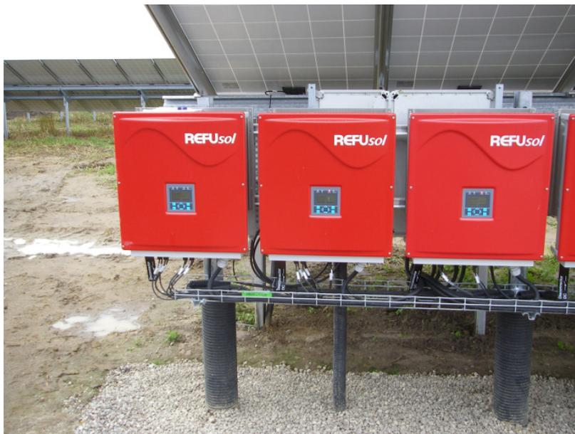
**Abb. 5:** Beispiel für eine unter den Modultischen stehende Wechselrichteranlage aus sechs einzelnen Wechselrichtern, hier Solarpark Kremmen. (Foto RIK: P7120004)
