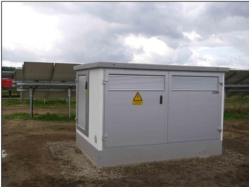
**Abb. 6:** Beispiel für einen Transformator, der den Wechselstrom von 400 V auf 20 KV hochtransformiert, hier Solarpark Kremmen.
