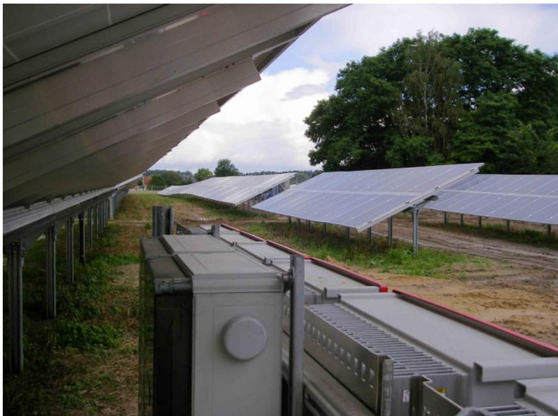
**Abb. 4:** Unterkonstruktion der Photovoltaik-Module mit nur einer Mittelstütze, hier Solarpark Kremmen. (Foto RIK: P7120009)
