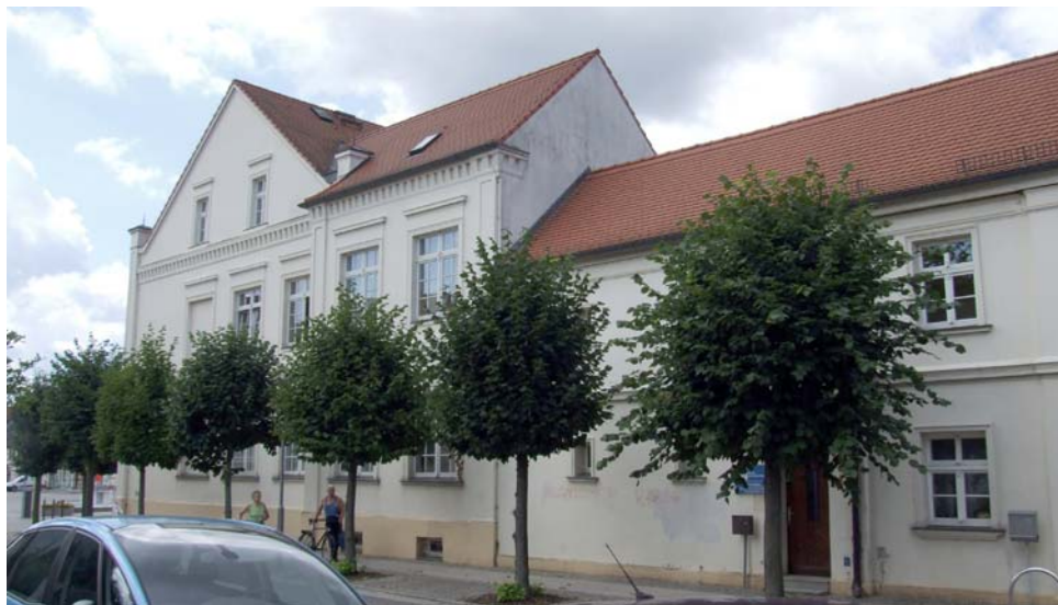
Ansicht von Osten. Gut erkennbar ist der Anbau an das Hauptgebäude, der dessen äußerliche Gestaltung übernimmt. Der ursprünglich freistehende Eckpfeiler des Hauptgebäudes ist eingebaut (Bild oben).
